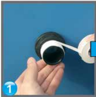
Etanșarea cu teflon sealing/ изоляция тefлоном
