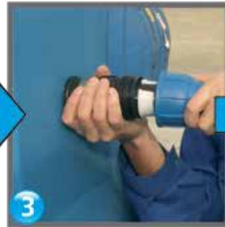
Conectarea tubului din polietilenă la racordul de compresiune connecting hdpe pipe/ стыковка полиэтиленовой трубы с зажимной муфтой
