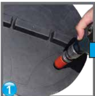
Se găurește capacul cu freză Ø 32 drilling the cap/ просверливание крышки
