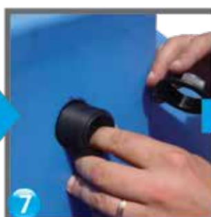
7 Se montează kitul niplu-piuliță mounting the connector/ монтаж соединителя
