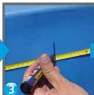
3 Se trasează centrul găurii marking the center of the hole/ центрирование отверстия
