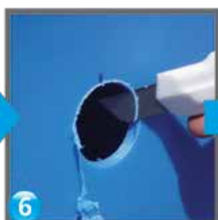
6 Se debavurează gaura finishing the hole/ обрезка
