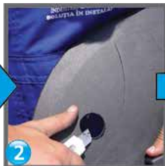
Se debavurează gaura finishing the hole/ обрезка
