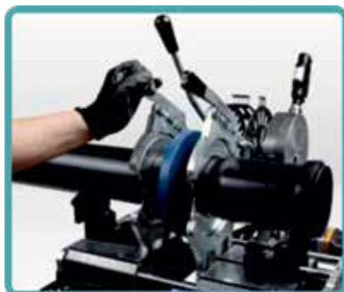
Sudură cap la cap cu aparatul de sudură, pentru toate diametrele.
