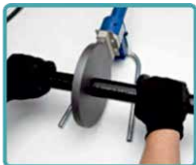
Sudură manuală cap la cap, până la diametrul 63 mm.
